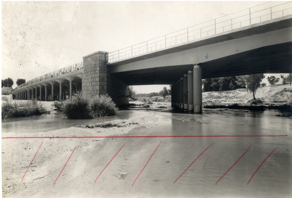
Vista del puente
