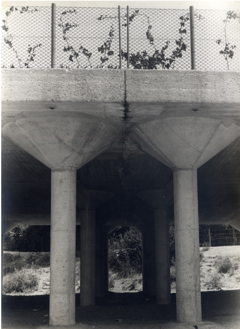
Detalle del puente
