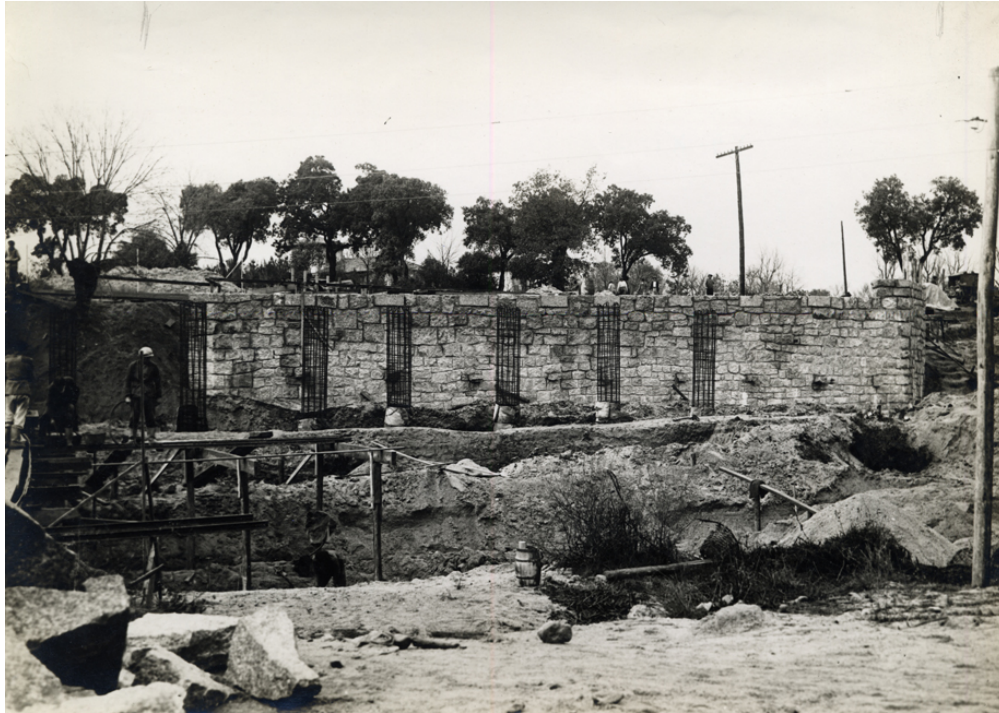
Vista del puente en construcción
