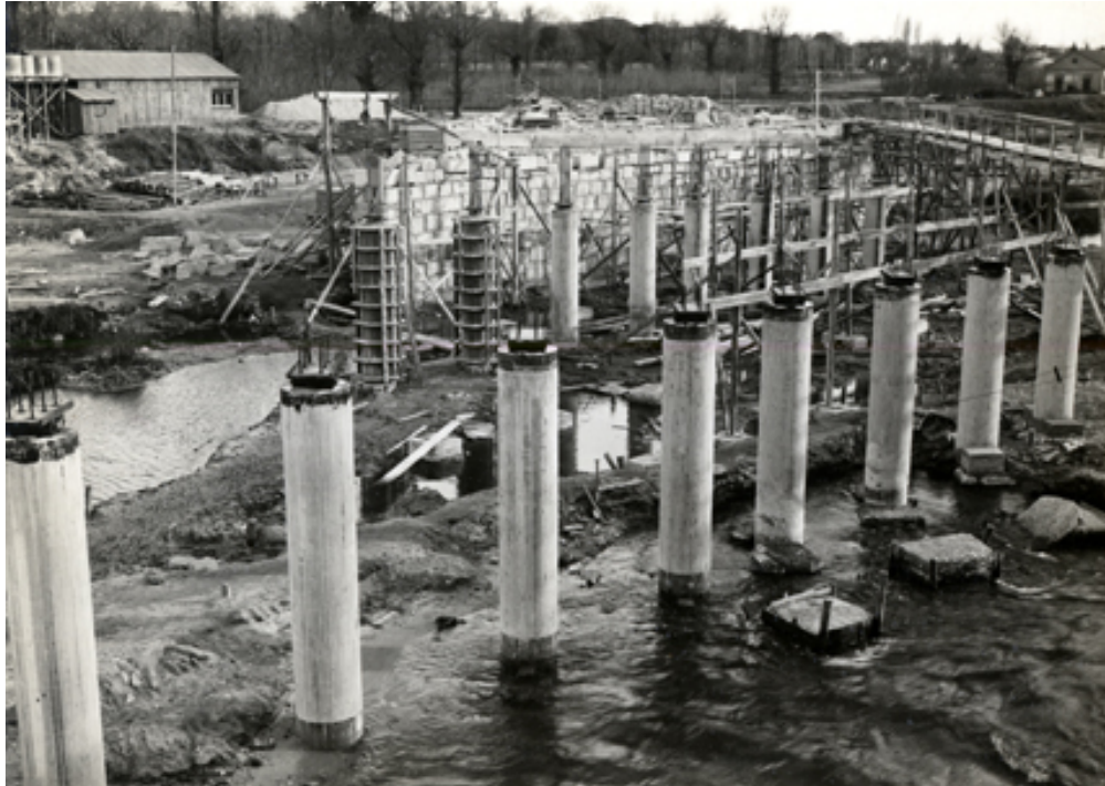
Vista del puente en construcción: pilares
