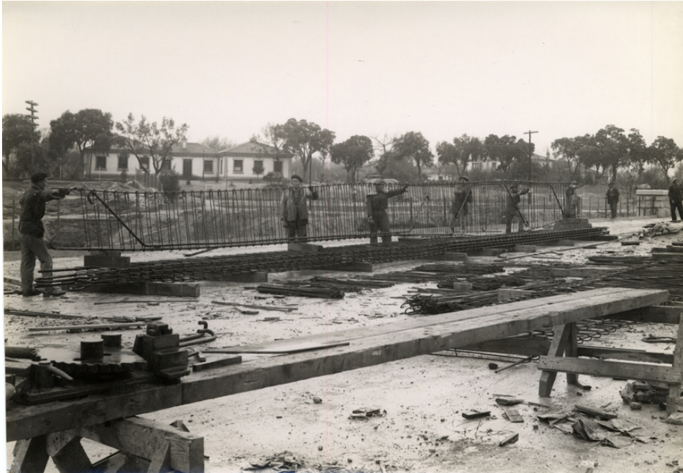
Detalle del puente en construcción
