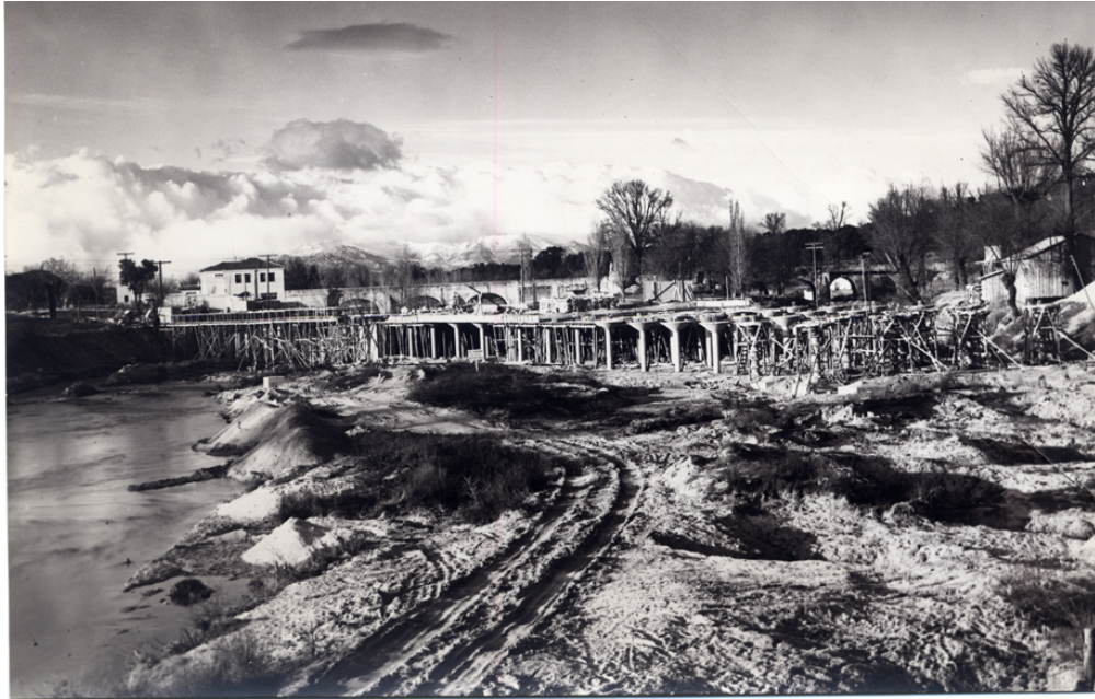
Vista del puente en construcción
