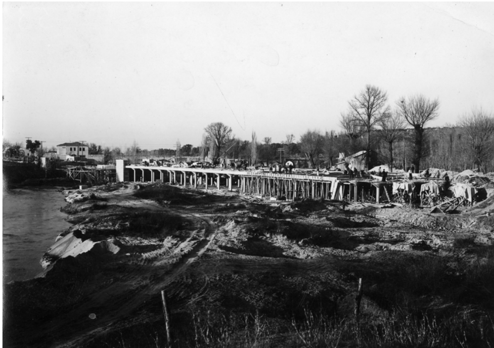
Vista del puente en construcción
