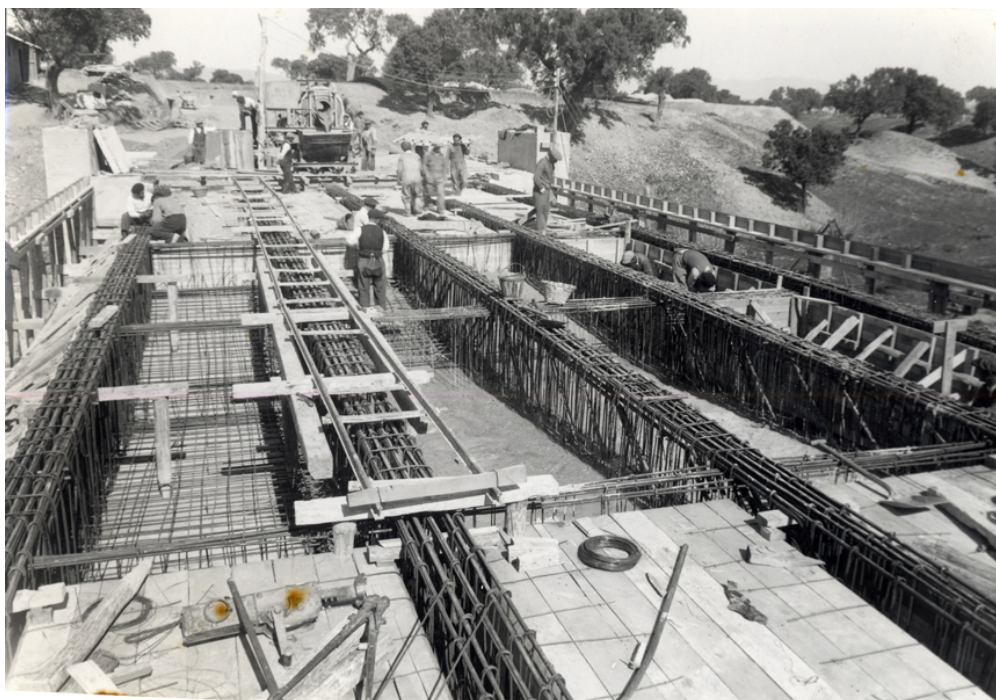
Detalle del puente en construcción
