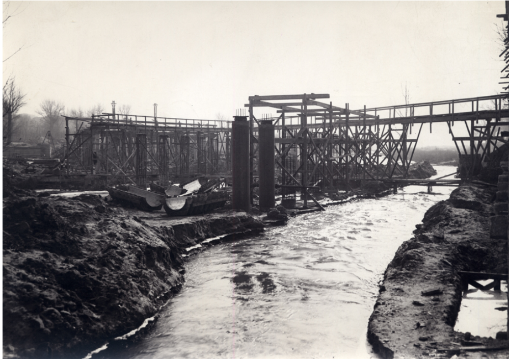
Vista del puente en construcción
