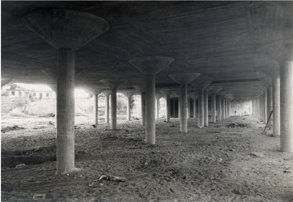
Detalle del puente en construcción
