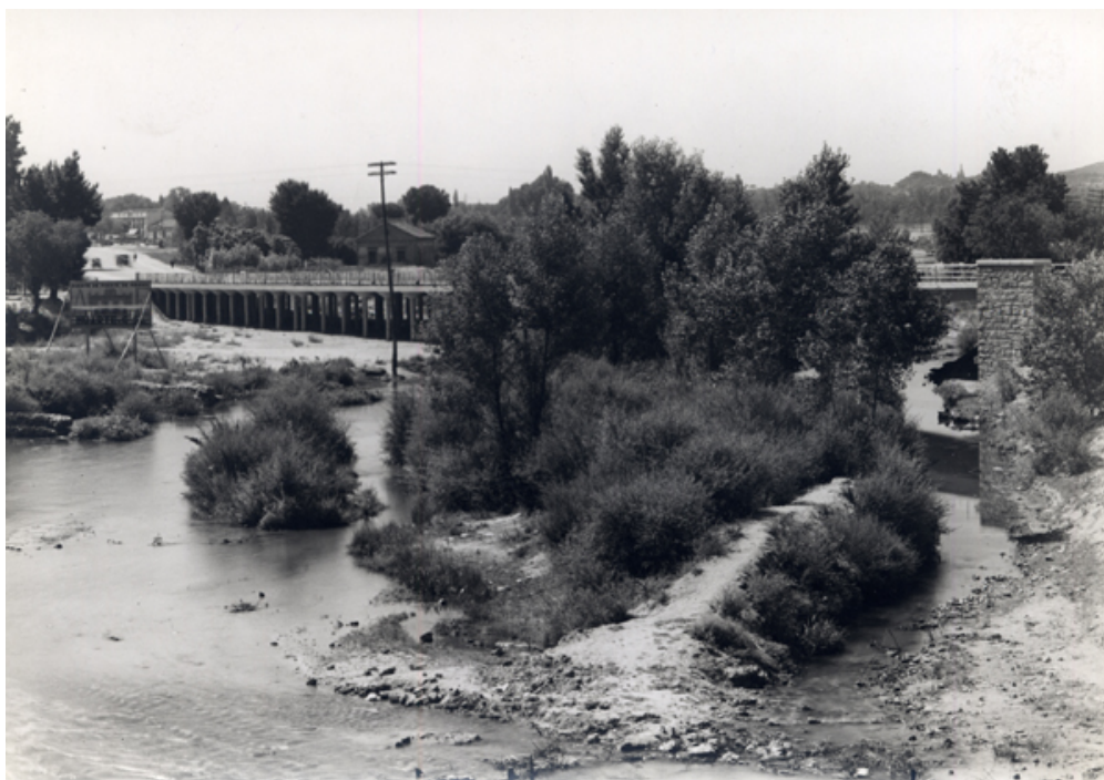
Vista del puente
