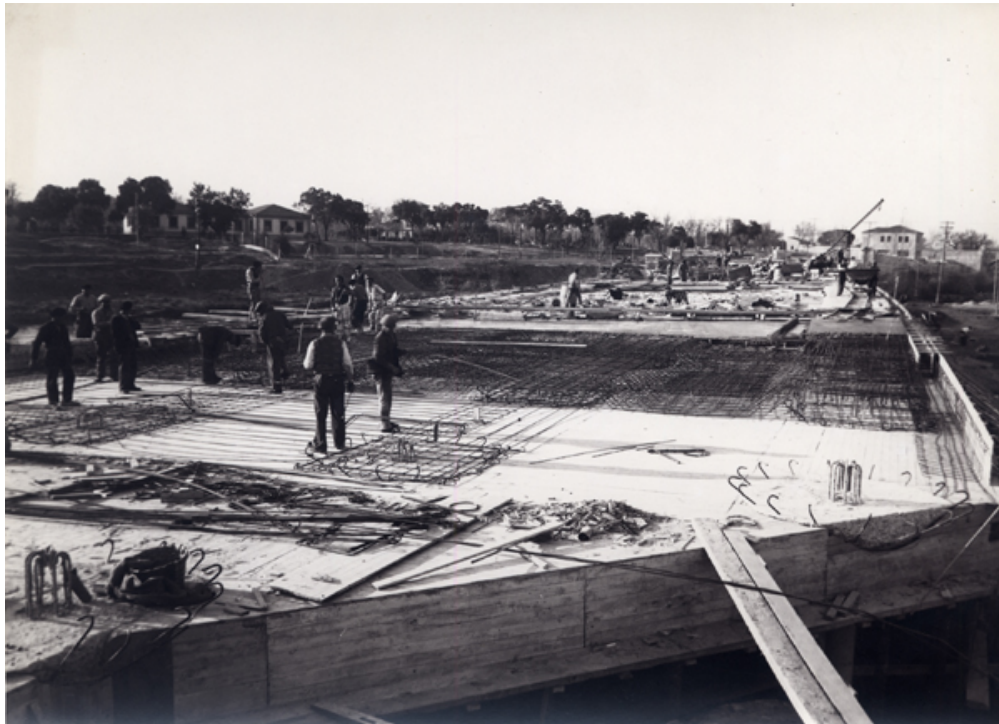
Detalle del puente en construcción
