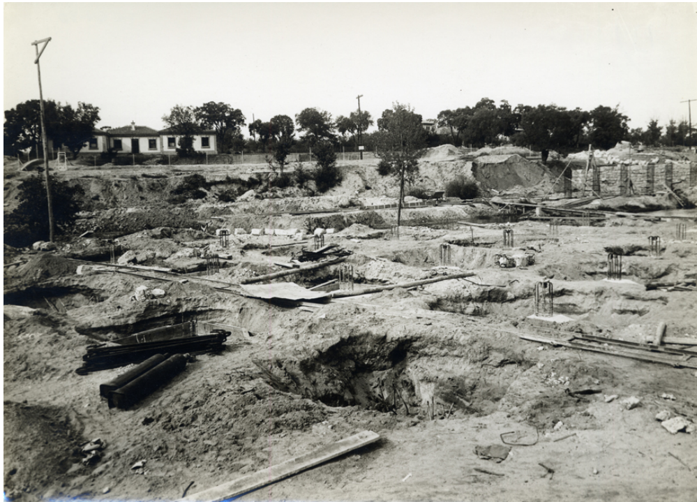
Vista del puente en construcción
