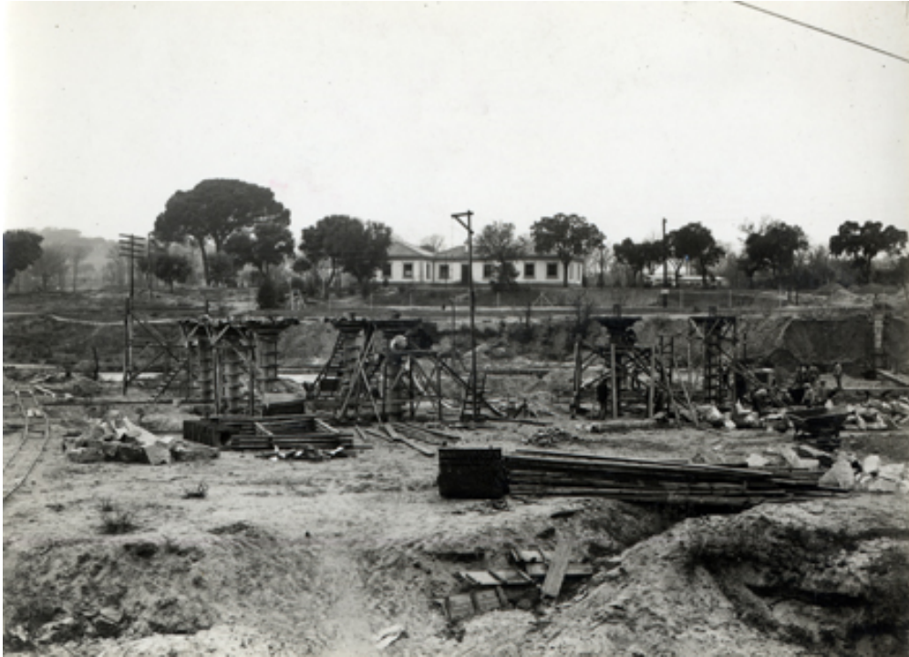
Vista del puente en construcción
