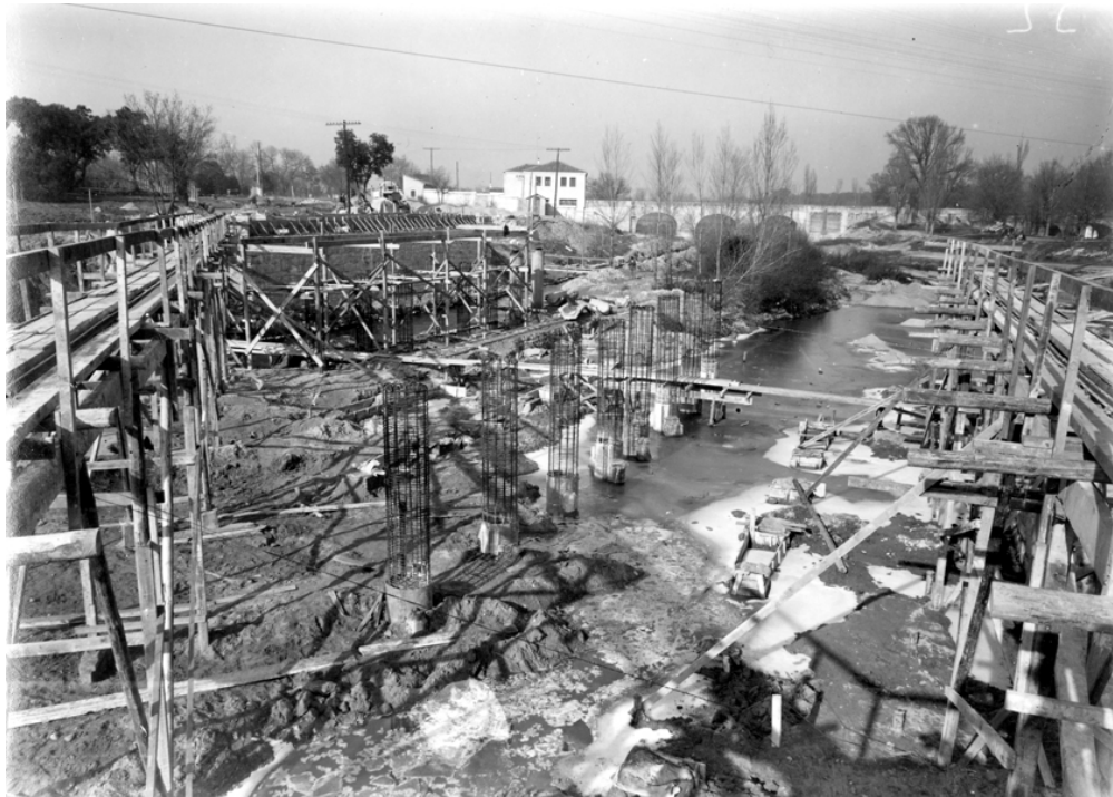
Vista del puente en construcción
