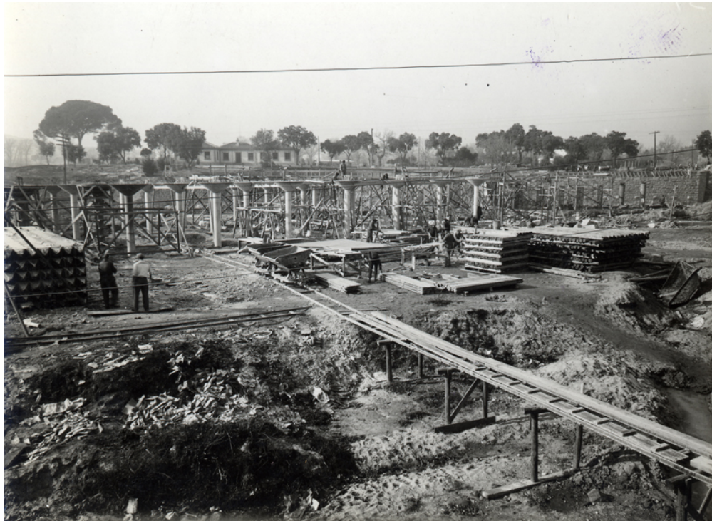
Vista del puente en construcción
