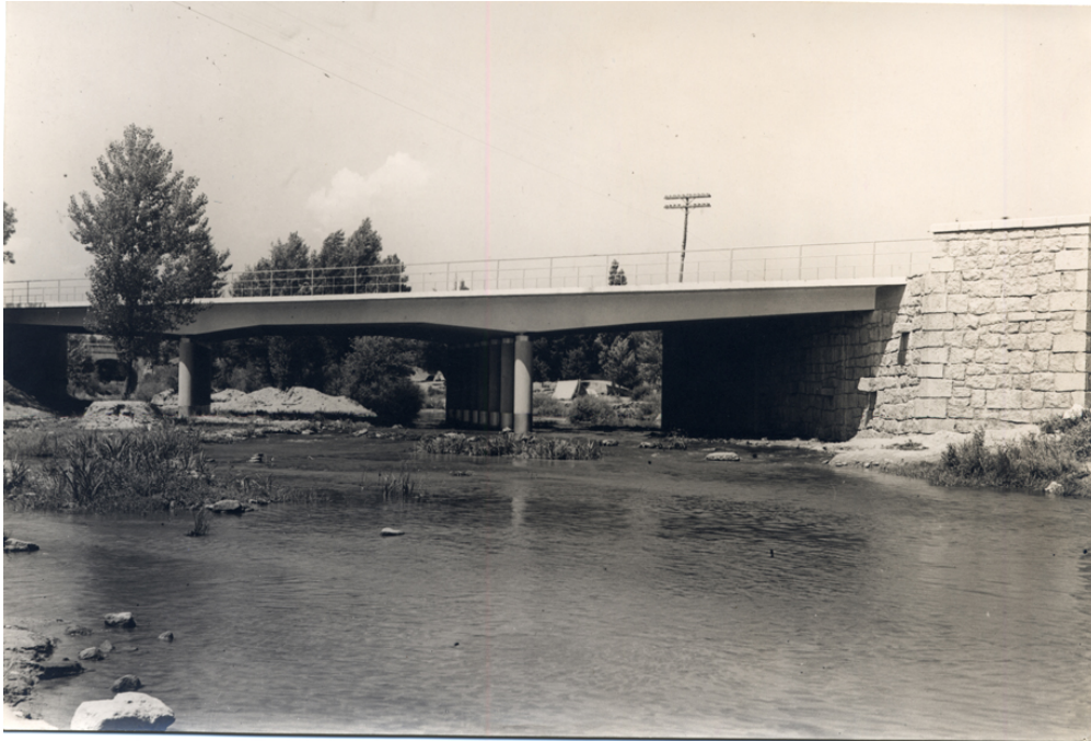
Vista del puente
