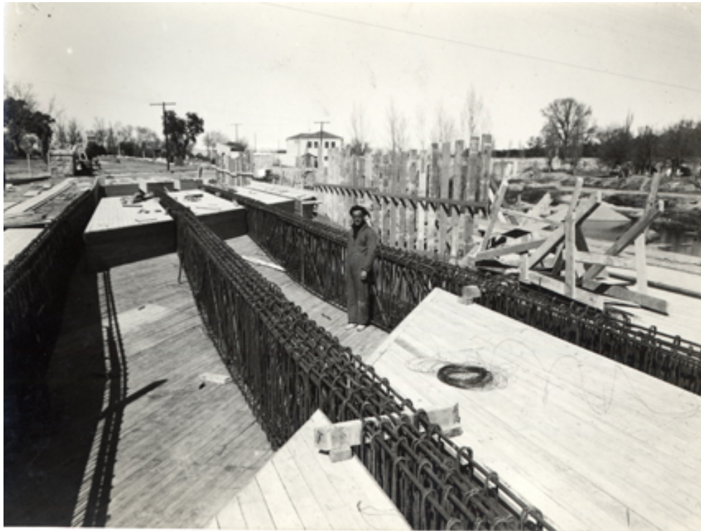
Detalle del puente en construcción
