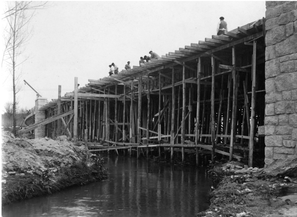
Detalle del puente en construcción
