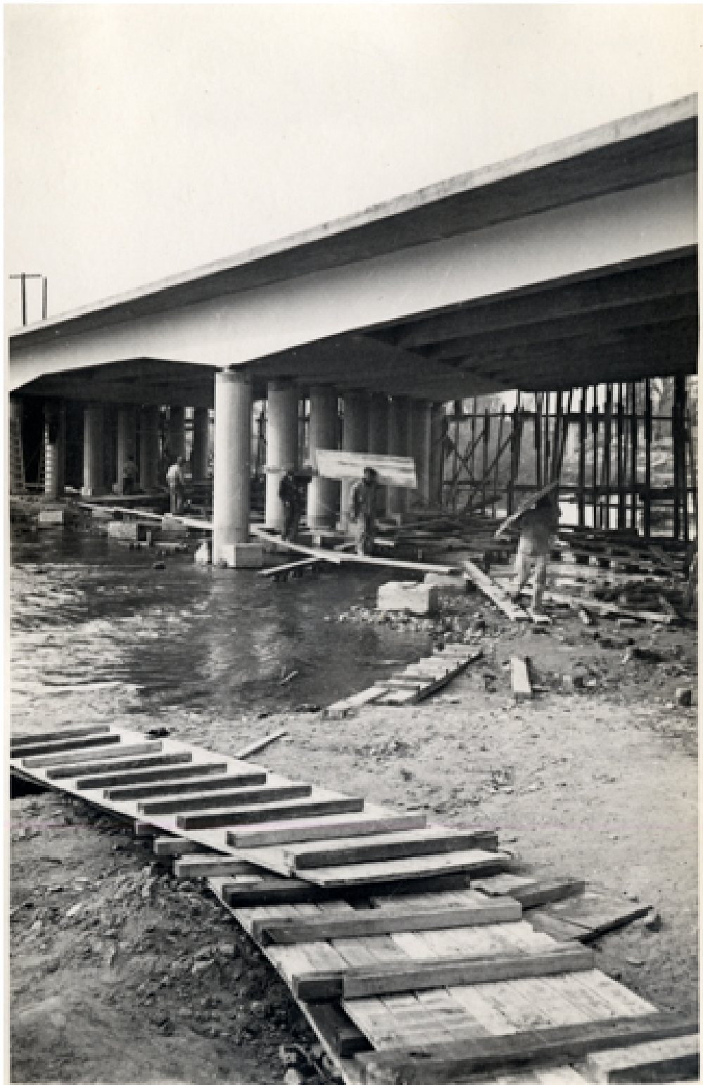
Vista del puente en construcción
