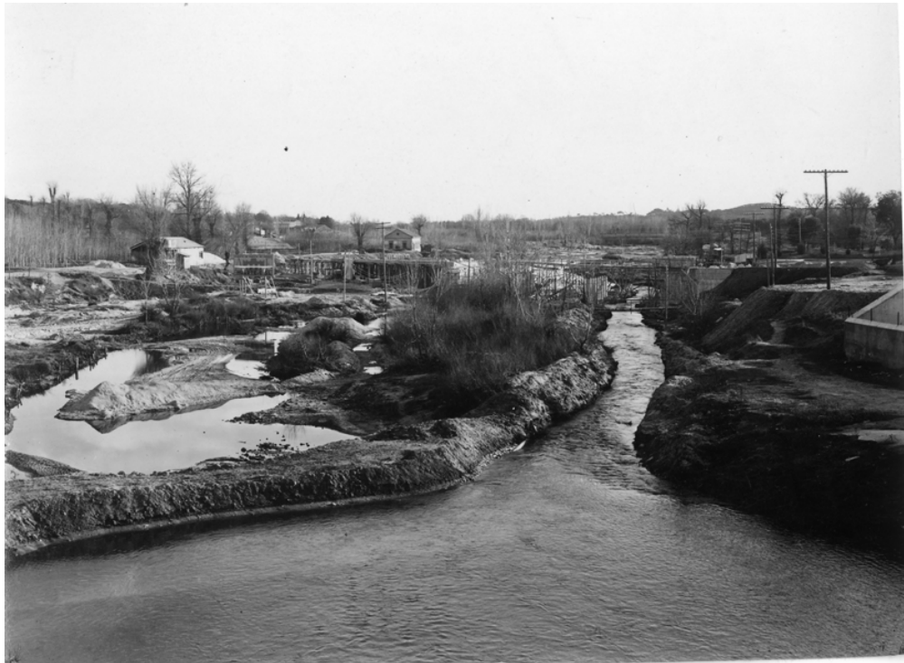
Vista del puente en construcción
