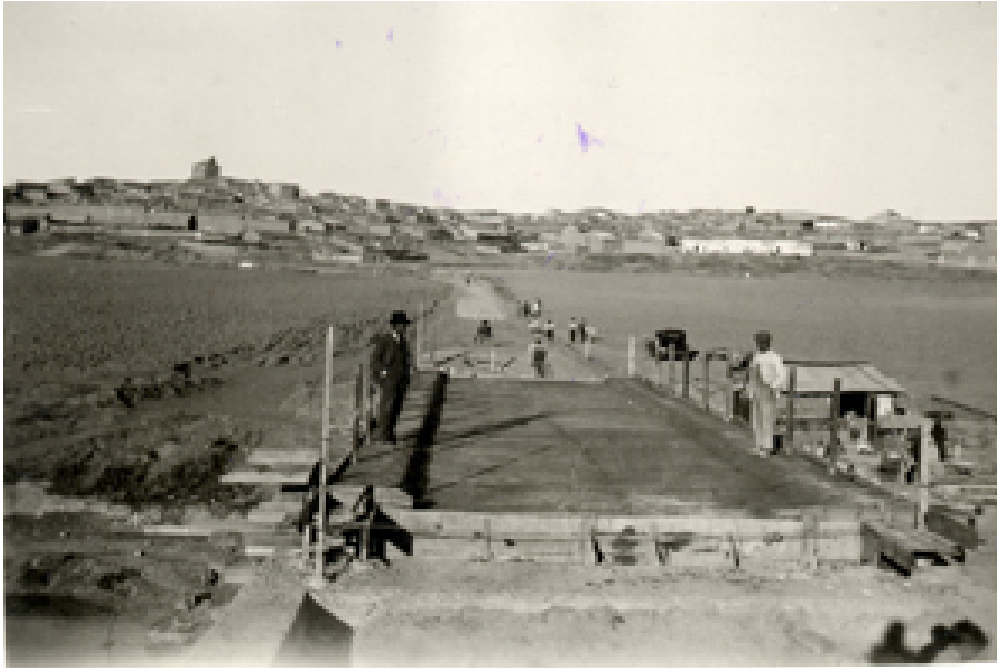
Vista del puente en construcción
