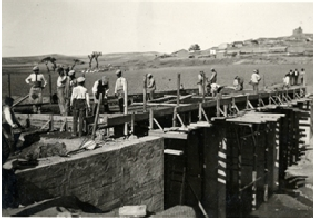
Vista del puente en construcción
