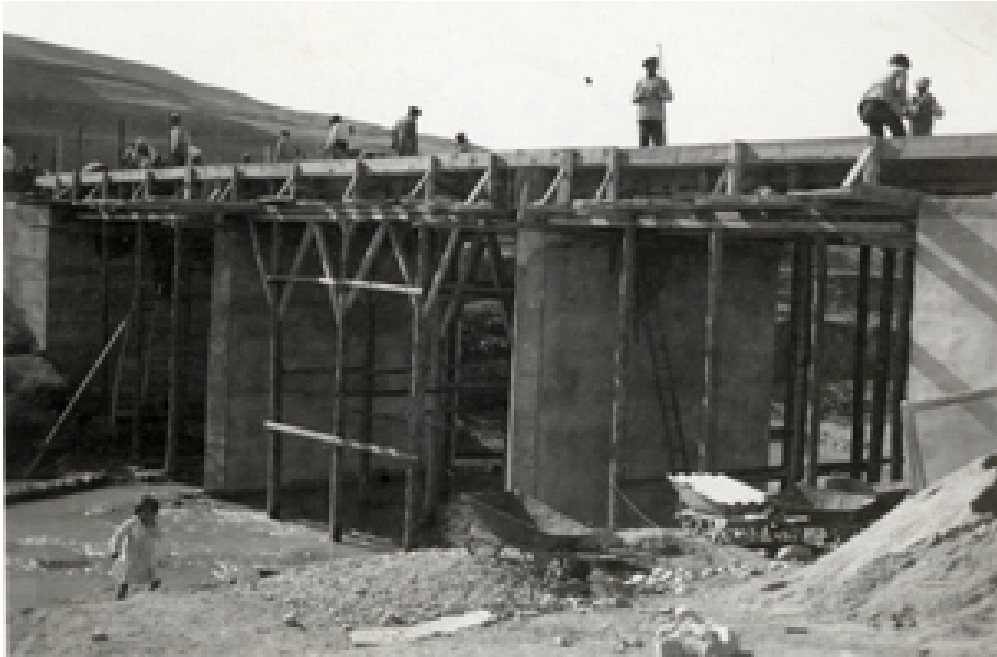
Vista del puente en construcción
