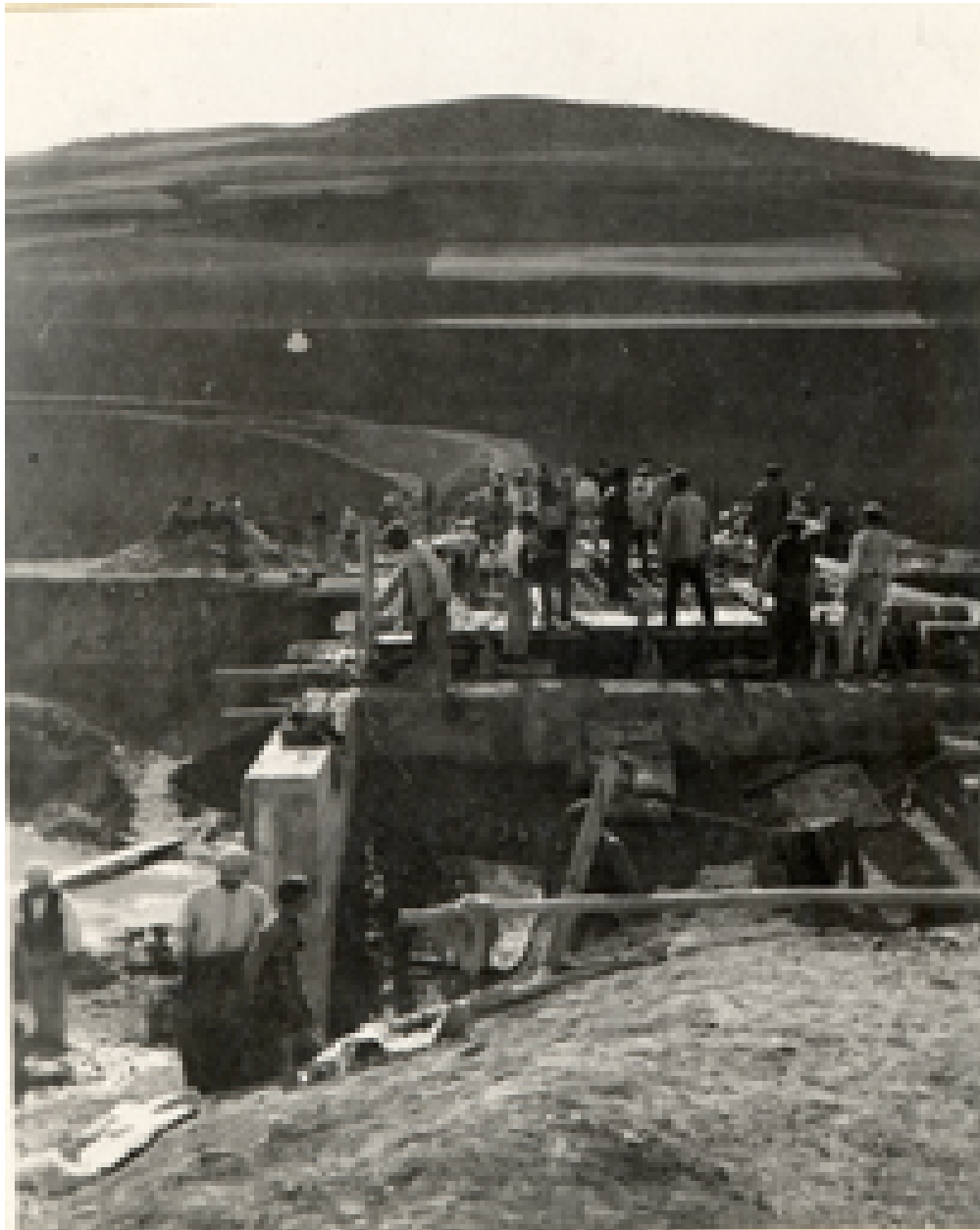
Detalle del puente en construcción
