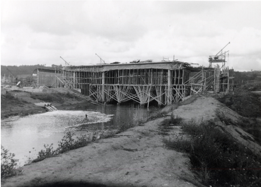
Vista del puente en construcción
